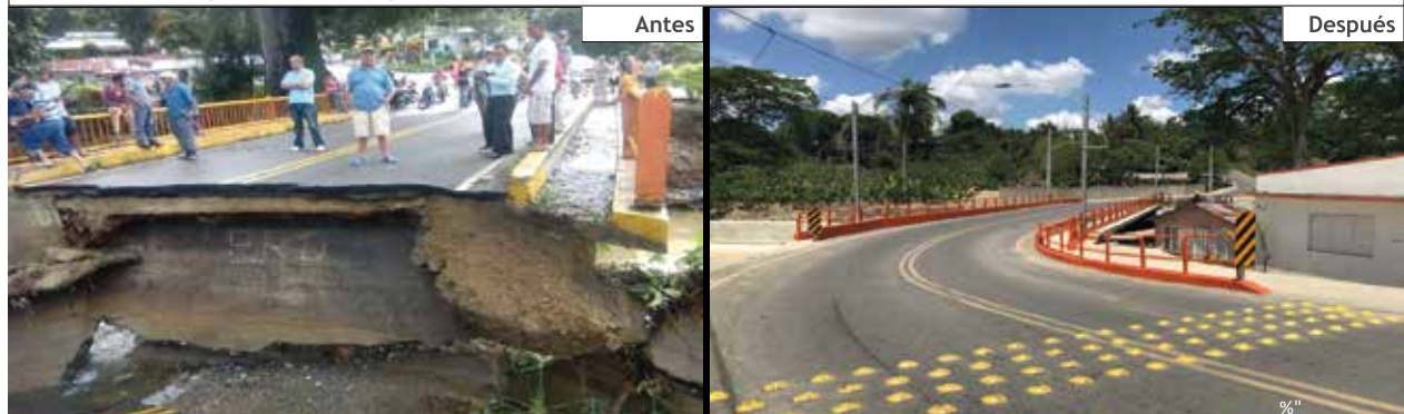
Puente Cajón sobre Río Cacique, Espaillat
