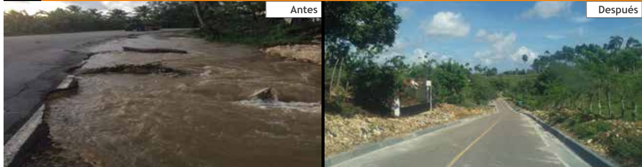
Cuneta en Carretera Payita, María Trinidad Sánchez
