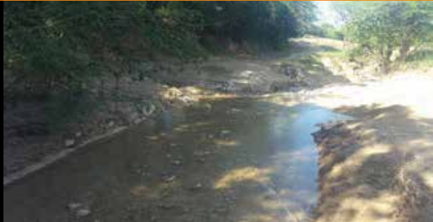
Alcantarilla en la Comunidad el Papayo con Puerto Juanita
