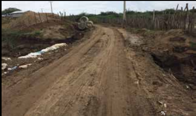
Camino Vecinal Carretera Duarte KM 4 - El Rincón
